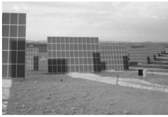
Fig. 3.12. Sombras simultáneas sobre un seguidor, proyectadas por otros dos ubicados al este y al sudeste, respectivamente.
